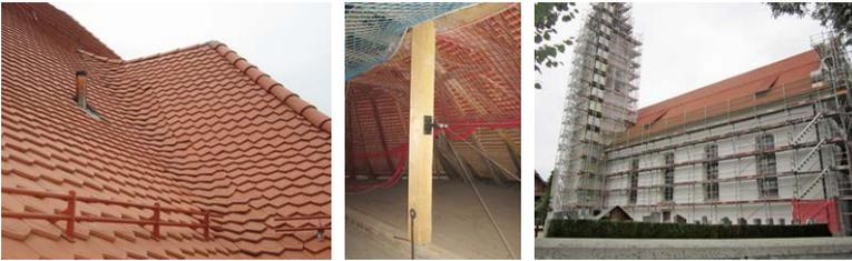
Die Restaurierungsarbeiten an der Pfarrkirche Ettiswil sind bereits weit fortgeschritten. Das Dach ist mit neuen roten Ziegeln eingedeckt, die Blechschindeln des Turmhelms sind neu gestrichen. Die letzten Spenglerarbeiten werden momentan an den Abdeckungen der Sandsteingesimse der Westfassade getätigt. Schadhafte Teile des Chordachstuhls wurden ersetzt und die Tragkonstruktion zusätzlich ausgesteift.
